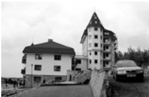
Zrekonštruovaná budova modlitebne
